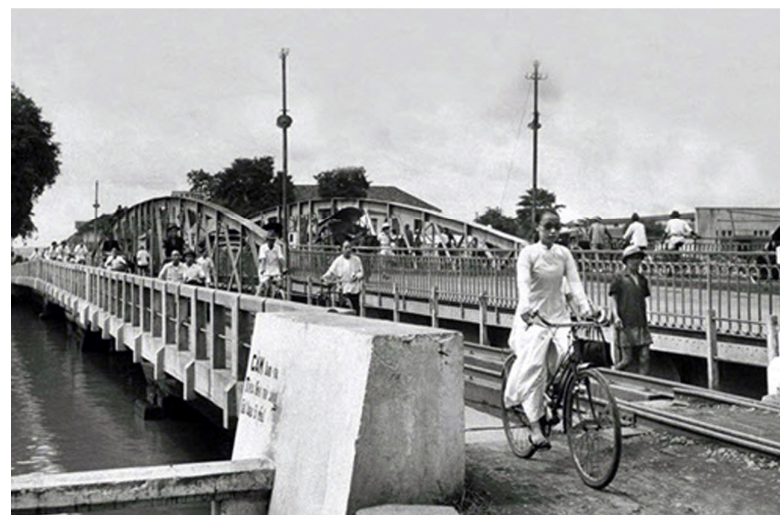
Vào khoảng thập niên 1940, khi đặt thêm đường sắt thì cầu quay được cố định (không còn quay nữa). Ảnh tài liệu.
